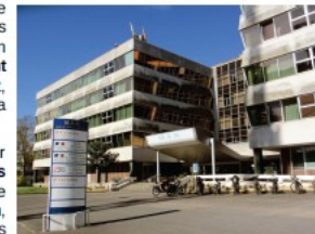
A Nantes, ce bâtiment regroupant 350 agents de l'État est chauffé par un réseau alimenté à 85 % par des ENR&R.
